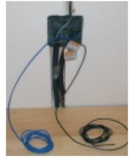
Jetzt noch eine Hin- und eine Rückleitung zum Regler einsetzen, schon können die Heizmatten in Betrieb genommen werden
