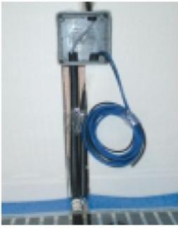
Sämtliche Anschlußleitungen werden in die Anschlußdose (Bestandteil des Regelsets) geführt.
