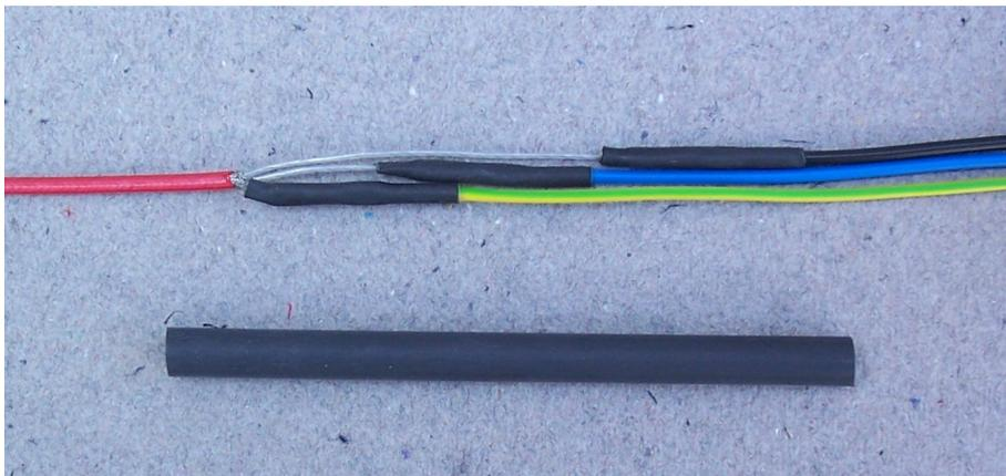
Die kleinen Schrumpfschläuche über die Quetschverbinder ziehen und einzeln mit dem Heißluftgebläse verschrumpfen, dabei darauf achten, dass der große Schrumpfschlauch die drei kleinen Schrumpfstellen sowie ca. 1cm des Heizkabels noch überdecken kann.
