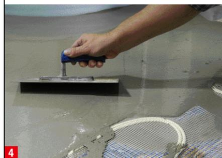
**4** Ausgleichsmassen sind relativ flüssig und verteilen sich fast selbsttätig. Mit einem Spachtel können Sie nachhelfen. Vorsicht: Die Massen ...
