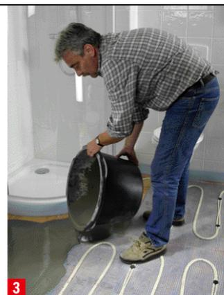
Verwenden Sie flexible Ausgleichsmasse, hier Fließspachtel Faserflex. Diese Produkte haben mit thermischen Spannungen weniger Probleme
