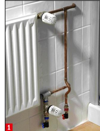
Die Heizmatte kann an bestehende Heizkörper angeschlossen werden. Der Abgang zur Bodenheizung muss aber vor dem Heizkörperthermostat sitzen!
