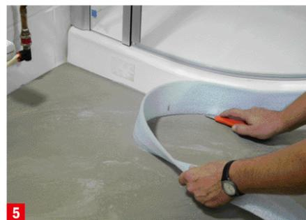
... binden oft sehr schnell ab und es bilden sich eventuell wieder Unebenheiten. Nach Austrocknung schneiden Sie den Dämmstreifen bündig ab
